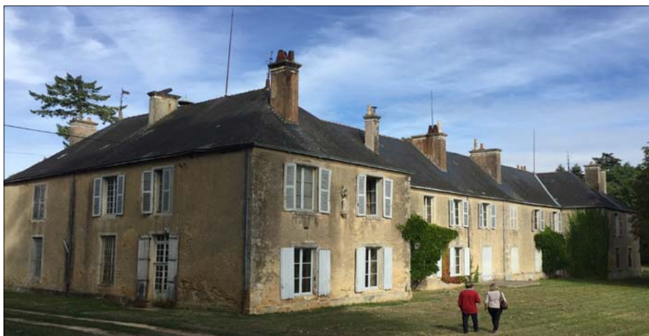
L'ancienne abbaye de Bonnevaux, futur centre international de la WCCM.
